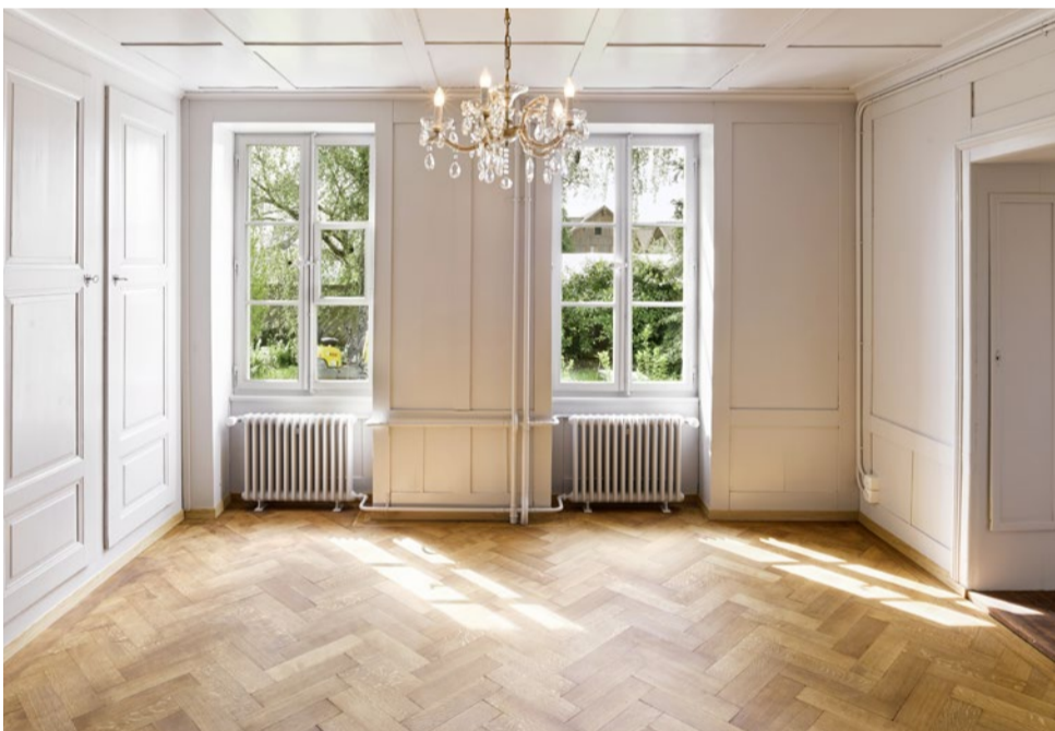
Das Holzwerk im Haus wurde von den nicht mehr originalen Farbschichten befreit und mit dem hellgrauen Farbton der damaligen Berner Herrschaftshäuser versehen.
